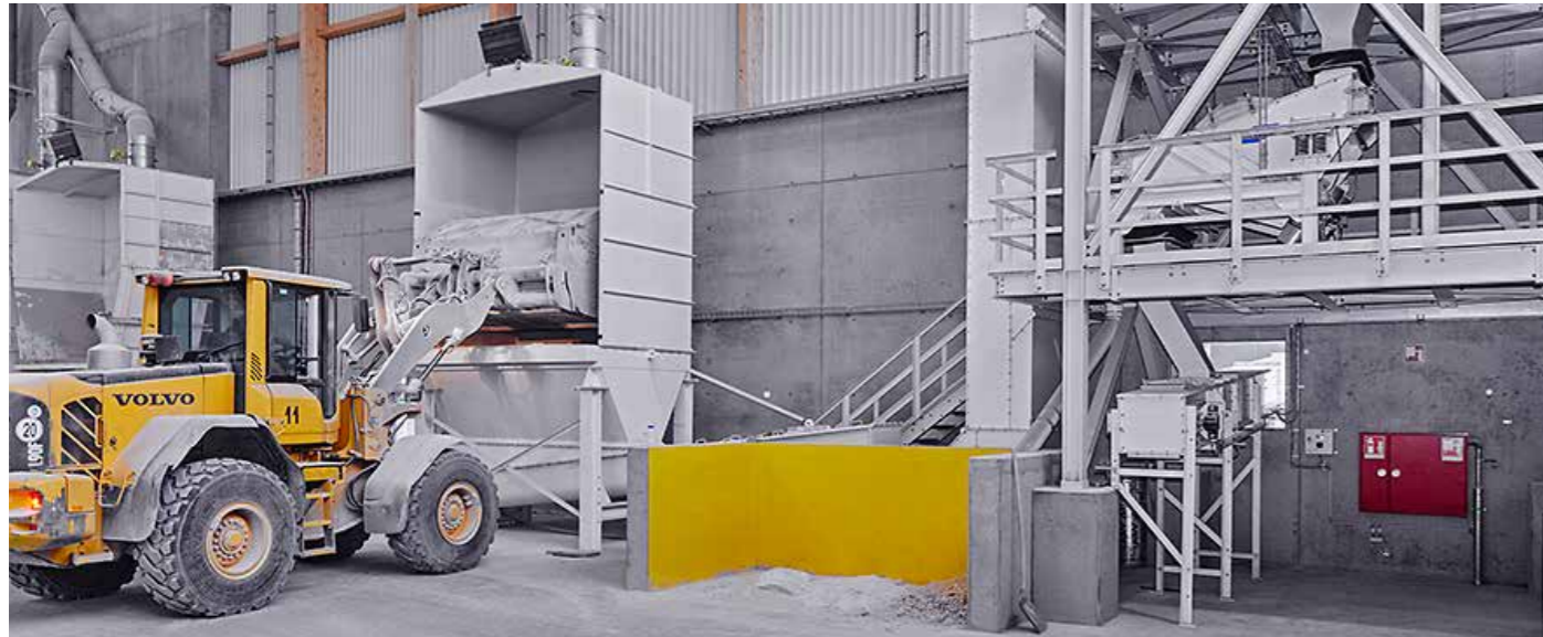
1 - Carico dell'impianto con le materie prime
